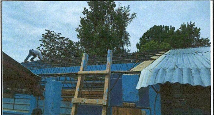
Foto 4: cambio de techo de aula de parvulos.
