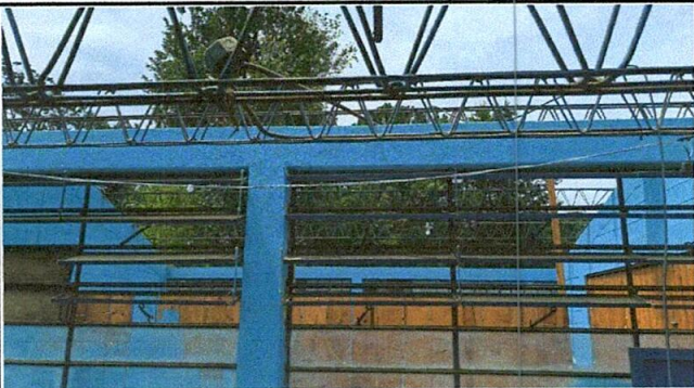
Foto 5: techo de modulo de parvulos.
