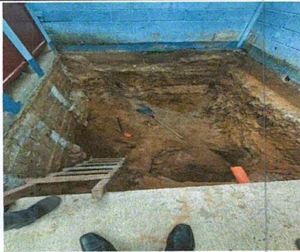
Foto 3: construccion de la fosa septica.
